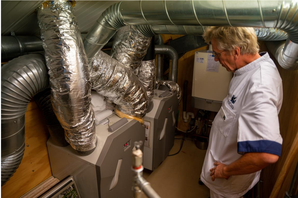
Dierenarts Anton Fennema bij de warmteterugwinningsinstallatie van zijn praktijk. “Hierdoor hebben we een laag gasverbruik, ookal hebben we een grote ruimte.” Beeld Stephanie Broekarts
